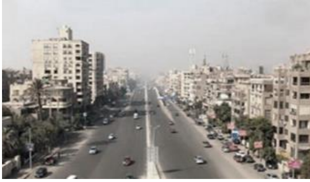
صورة رقم ٣ شارع أبو بكر الصديق بعد التحور العمراني صورة بتاريخ ٢٠٢١/١١ ويظهر فيها انشاء كوبري للسيارات وتضييق الأرصفة الجانبية ومحور الجزيرة الوسطي وما كان بها من ممرات مشاة المصدر: الباحث
