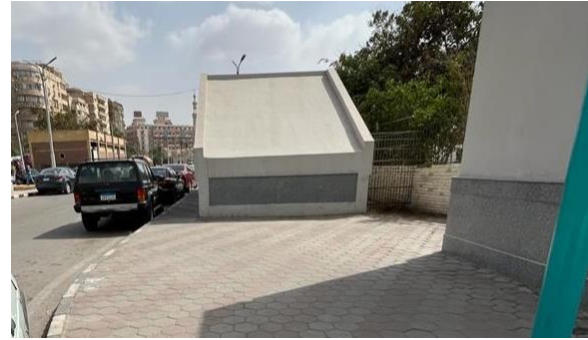
صورة رقم ٣٢ رصيف جانبي عريض بجوار المستشفى ويظهر بها عائق لحركة المشاة غرف الكهرباء لمحطة المترو. تصوير الباحث يناير ٢٠٢٣
