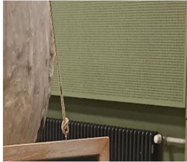
تشطيبات حوائط بأماكن الانتظار مفرغة لتفريغ الصوت وعدم الترددات الصوتية لتحقيق الراحة صوتية
